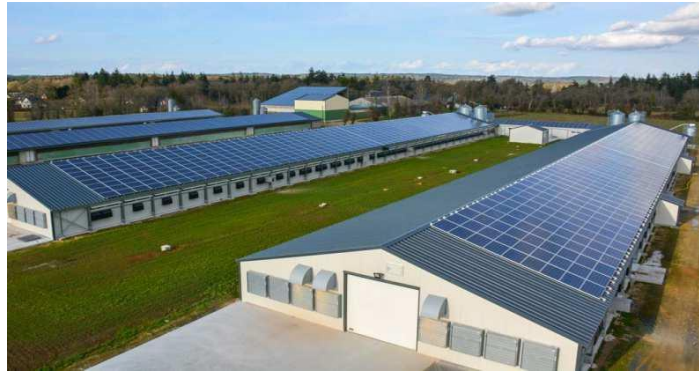
Figure 9: Bâtiment muni de panneaux solaires (PaysanBreton, 2017)
