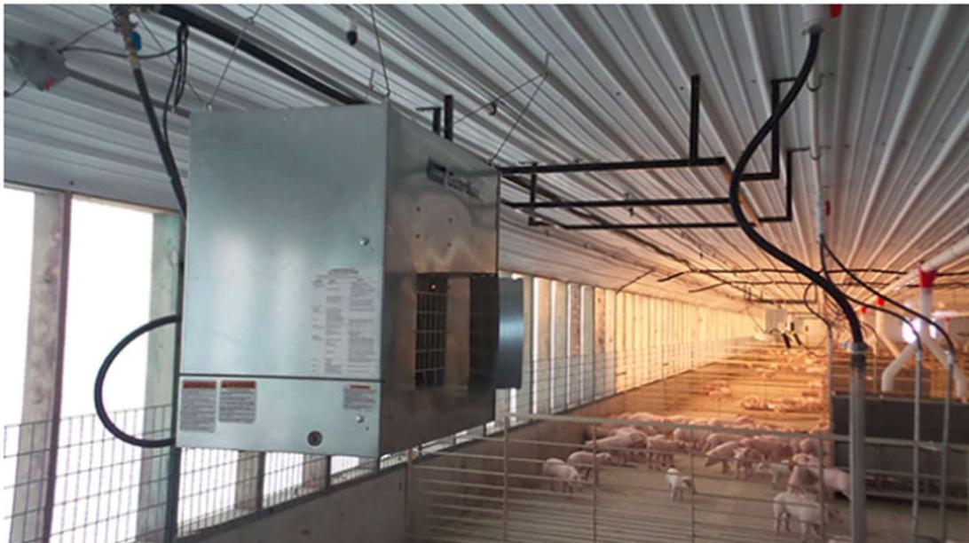
*Figure 12. Appareil de chauffage L.B. White Guardian en pouponnière*
