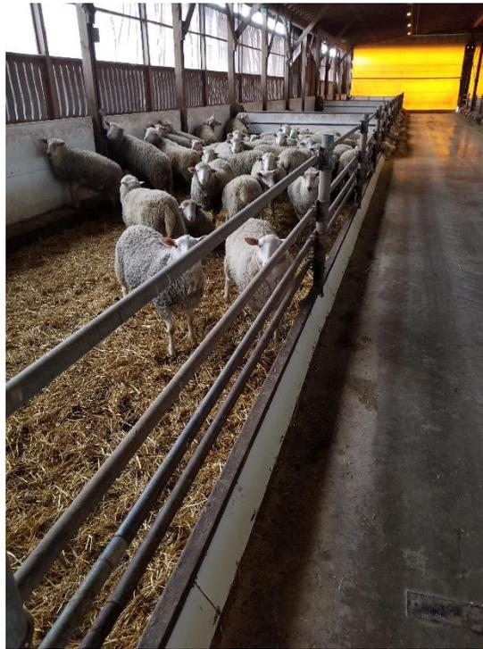
**Figure 10 : Parc avec barrières en acier et mur en plastique**
