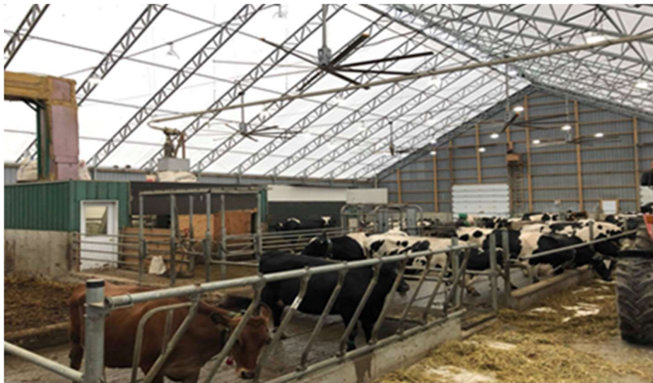
Figure 1 - Vue intérieure de l'étable et des ventilateurs à débit élevé et à vitesse faible
