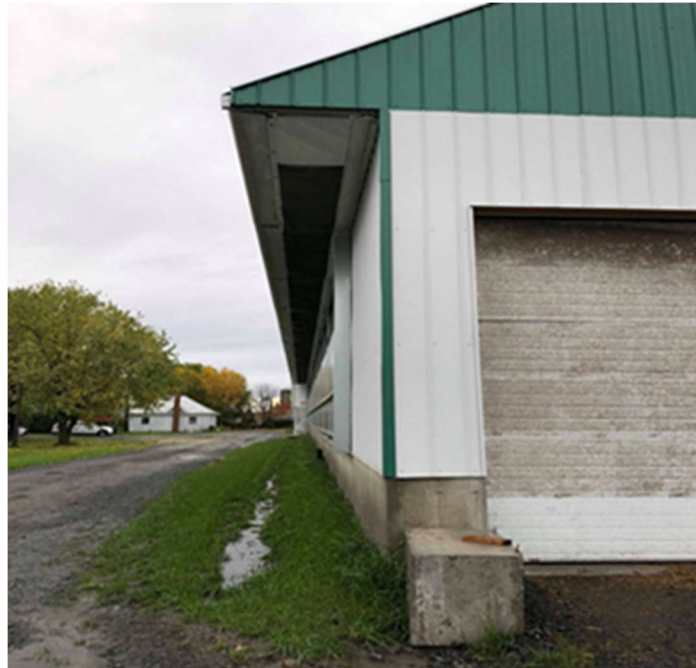
Figure 20 - Ventilation avec corniche
