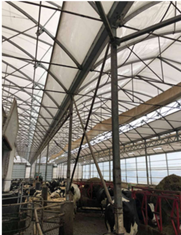
Figure 27 - Système de ventilation
