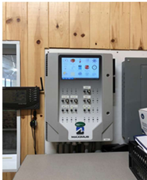
Figure 29 - Système de contrôle Maximus dans l'étable conventionnelle
