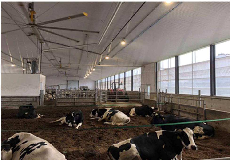
Figure 6 - Toiles, ouvertures d'entrée d'air, ventilateurs à débit élevé et à vitesse faible et vaches en gestation
