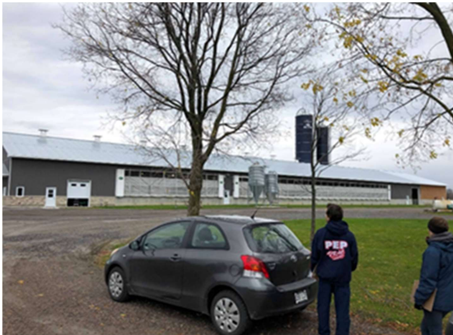
Figure 5 - Bâtiment vu de l'extérieur
