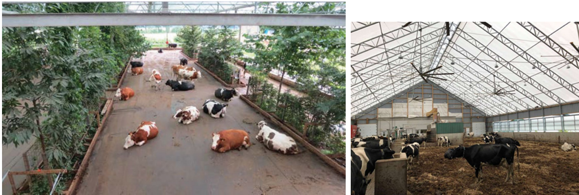
Figura 1. Graneros con FWHS: huerto lechero con suelo artificial y árboles (izquierda; Galama et al., 2020) y zona de camas abonadas con techo solar (derecha; Blouin et al., 2020)
